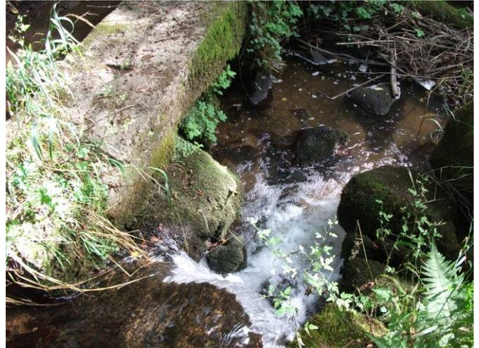
Vue sur l'ouvrage, affouillement visible sous la partie bétonnée
