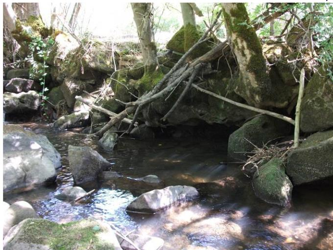
Vue sur la berge rive gauche en aval de l'ouvrage, protection par un mur en pierre déstabilisé par les racines d'un arbre, entraînant l'affouillement de la berge
