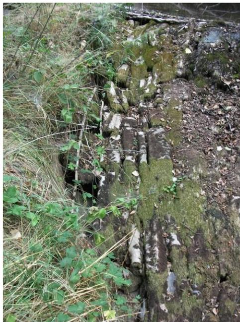
Vue sur le côté droit de l'ouvrage, avec déstabilisation des pierres entraînant un écoulement interne
